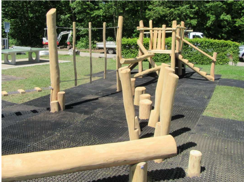
Frisch verlegt und humusiert
