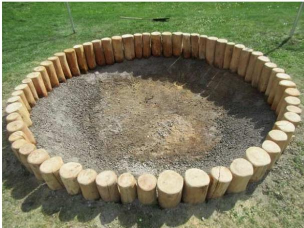
Der Sandkasten wird mit Robinienpalisaden zusammengebaut.
